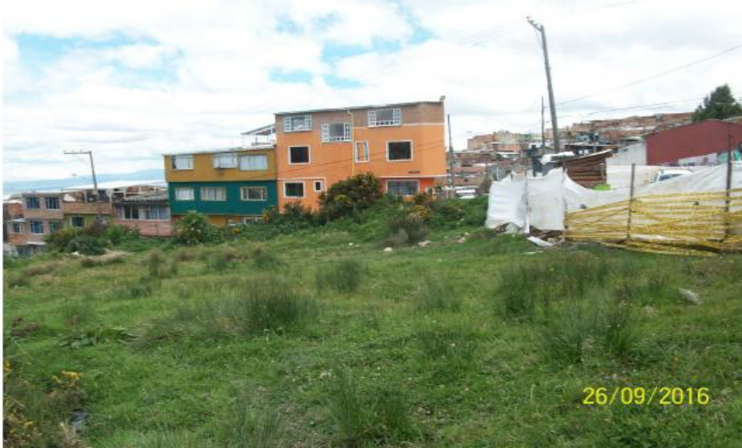
Fotografía 6. Punto de intervención del box coulvert No. 1, para el acceso al proyecto urbanístico "MIRADOR DEL ESTE", en donde se evidencia la presencia de zonas húmedas sobre el Corredor Ecológico de Ronda de la quebrada San Camilo.
