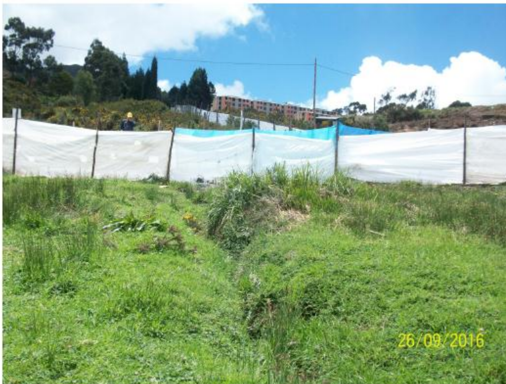
Fotografía 2. Punto de intervención del box coulvert No. 1, para el acceso al proyecto urbanístico "MIRADOR DEL ESTE".
